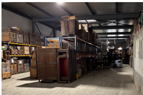
L'espace redéfini aujourd'hui, avec notamment l'installation de racks centraux
